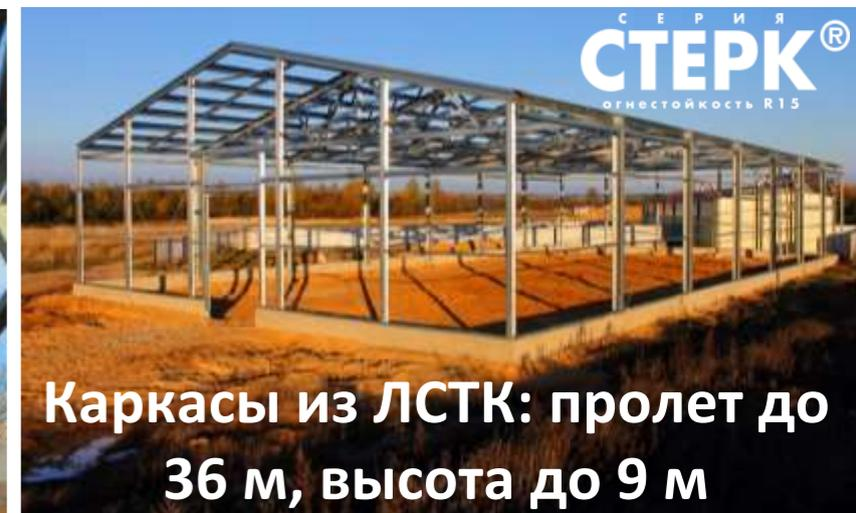
Каркасы из ЛСТК: пролет до 36 м, высота до 9 м
