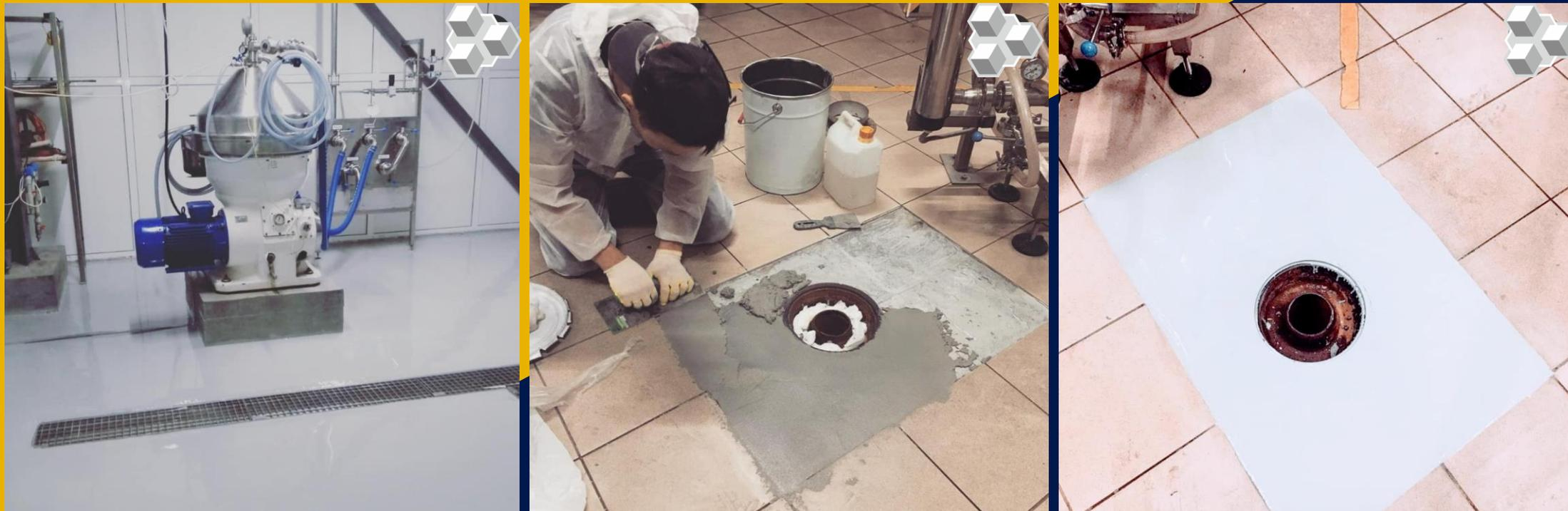
Для устройства стоков применяются композитные составы CERAMET-БЕТОН С1 или С2. Составы устойчивы к воздействию агрессивных химических реагентов (в том числе растворов кислот с концентрацией до 10-20%), не выделяют вредных веществ в процессе эксплуатации даже при постоянном воздействии жидкостей.
