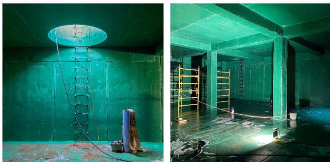
РЕЗЕРВУАРЫ ЧИСТОЙ ВОДЫ С ОБЛИЦОВКОЙ ФУТЕРОВОЧНЫМ ЛИСТОМ ПИТЬЕВОГО КАЧЕСТВА.
