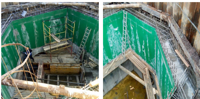
ВОССТАНОВЛЕНИЕ КАМЕРЫ СБРОСА КАНАЛИЗАЦИОННОГО КОЛЛЕКТОРА
