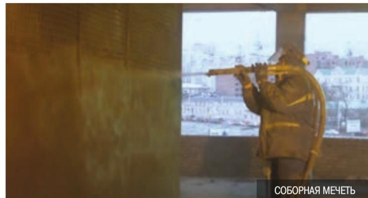
**КТрон-торкрет М - сухая смесь, состоящая из цемента, минерального заполнителя и модифицирующих добавок. При смешивании с необходимым количеством воды образует высокопрочный безусадочный тиксотропный раствор.**
